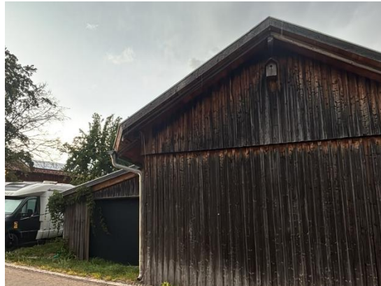
Abbildung 13: Ansicht Giebelseite eines der Gebäude für Ersatzquartiere
