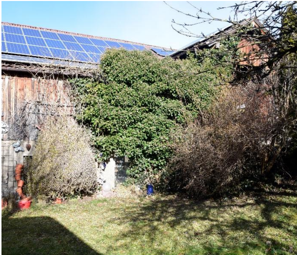
Abbildung 3: Bruthabitat Haussperling an Gebäude Nr. 7
